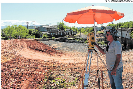
TOPOGRAFIA: Vargas fez medições no local ontem pela manhã
